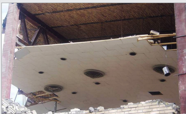
شکل ۱۶: اجرای سقف‌های کاذب با روش سنتی
